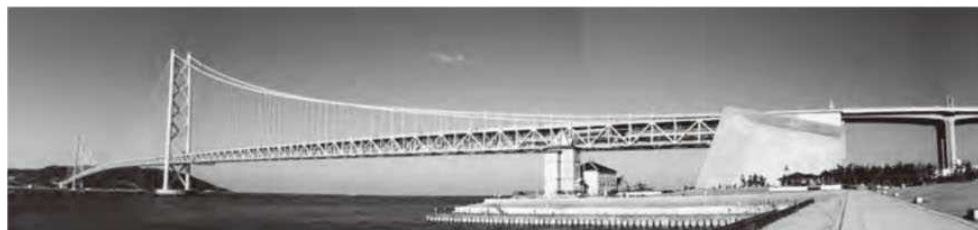
明石海峡大橋
